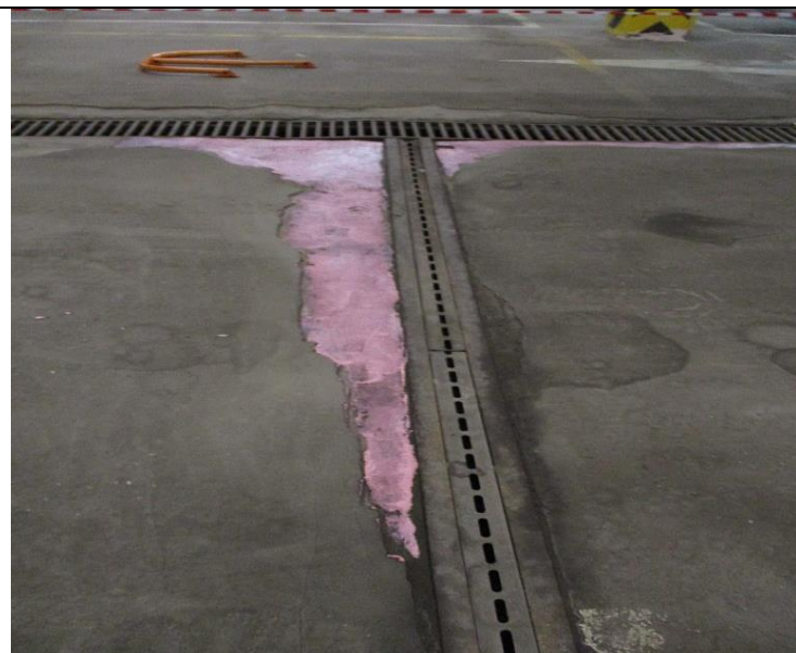
Кор.4, эт.-1 Нижний уровень паркинга Восстановление покрытия в проезде -приготовление и укладка раствора
