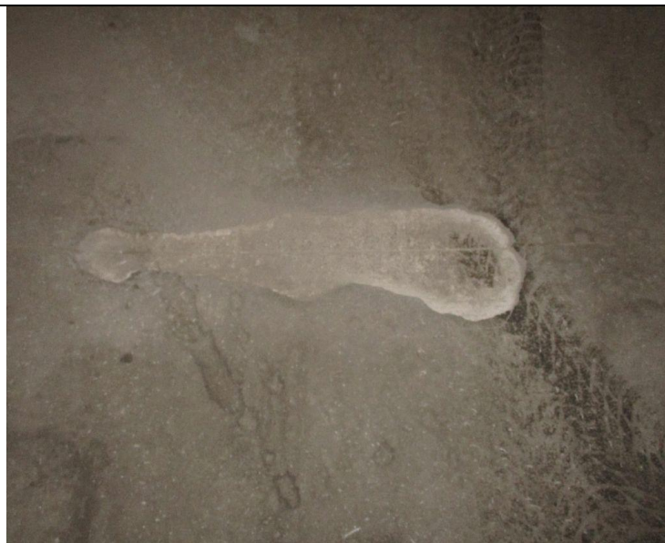
Кор.4, эт.-1 Нижний уровень паркинга Восстановление покрытия в проезде -подготовка поверхности
