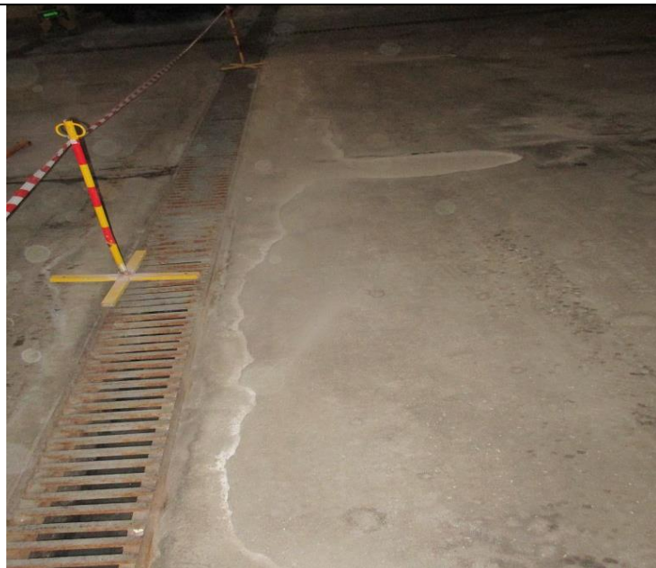
Кор.4, эт.-1 Нижний уровень паркинга Восстановление покрытия в проезде -подготовка поверхности
