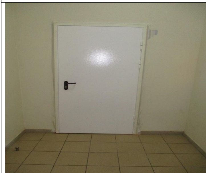
Кор.4, эт.1 коридор Замена сломанного дверного блока -оштукатуривание откосов
