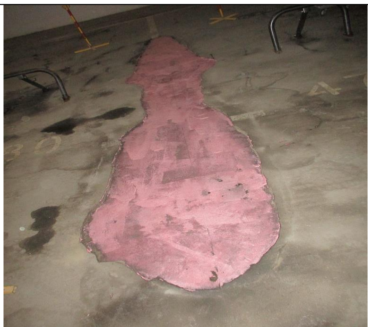
Кор.4, эт.-1 Нижний уровень паркинга Восстановление покрытия в проезде -приготовление и укладка раствора
